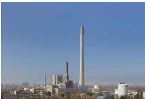
Abbildung 12: HKW-Mitte (Quelle: BS|ENERGY)
